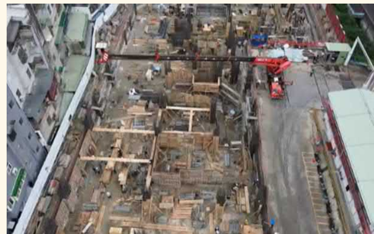
▲ 圖為工地空拍照片。
